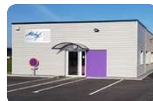
Antenne de Villers Bocage
